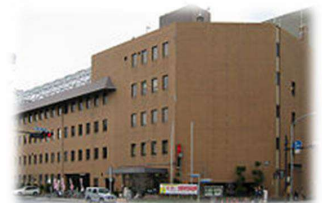
下京区役所(京都市)
